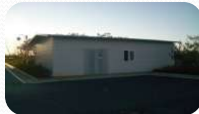
■ 정화 시설 전경
