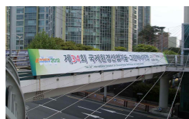
<Daechi-dong Daedo Overpass>
